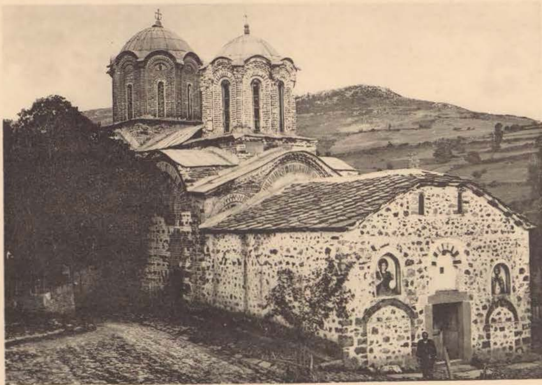
123. Lesnovo. Façade méridionale.
